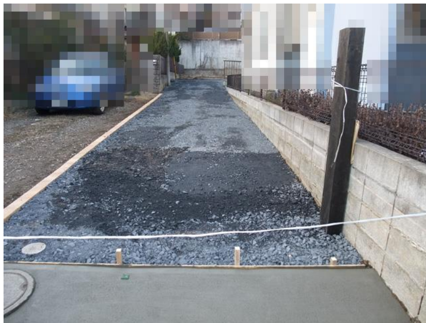
図 3-3 建設中の歩道
