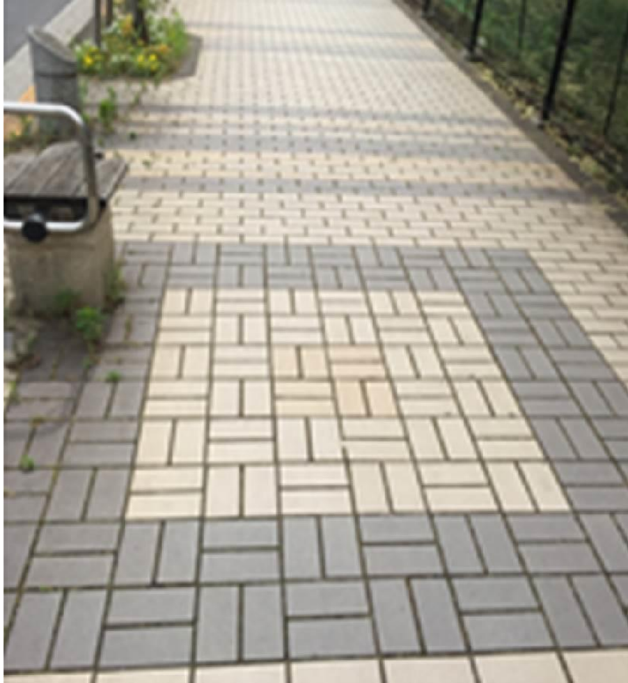
図 3-6 舗装タイル付き歩道
